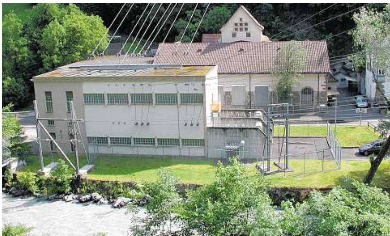
Wird auf Vordermann gebracht: Die drei seit 1947 bestehenden Maschinengruppen des Kraftwerks Sand in Chur werden bis im Frühjahr 2012 ersetzt.
